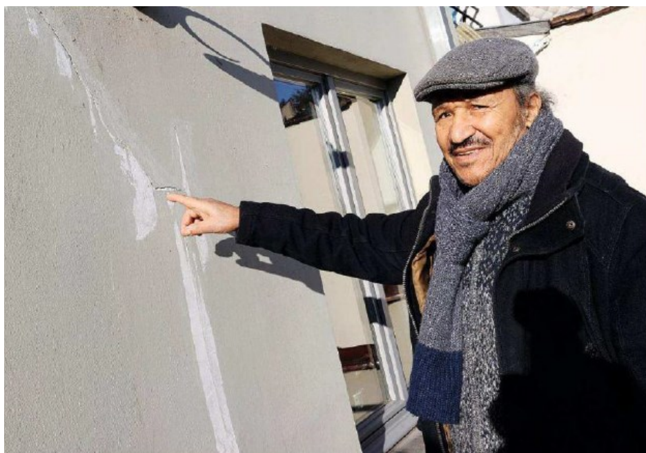
Cette année, de nombreuses fissures sont apparues dans l'habitation de Tejjeddine.
