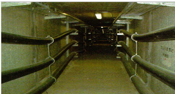
Ligne 400 000 V en tunnel
