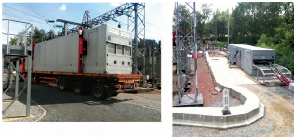
Figuur 2.3: Mobiel onderstation Herentals
