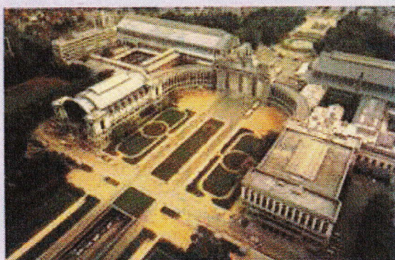
Vue aérienne du site du cinquantenaire. © klm-mra.
